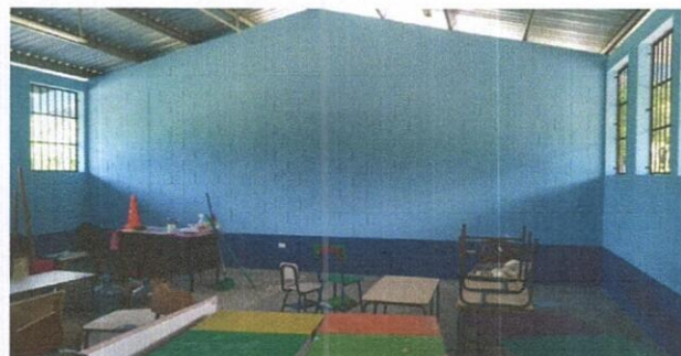
Foto 4: Pintura en muros exteriores e interiores.
