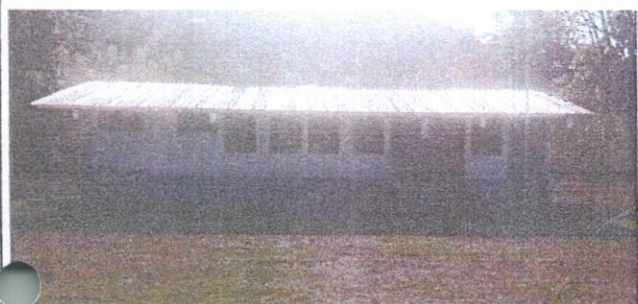
Foto 1: Sustrucción de lámina, sustrucción de capote y sustrucción de elementos de fijación.
