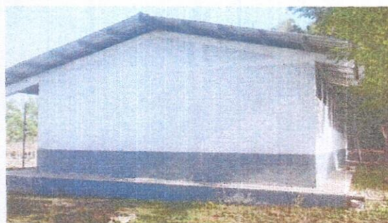
Foto 4: Pintura en muros exteriores e interiores.
