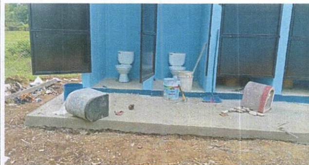
Foto 4: Cambio de letrinas por suministro de inodoros lavables
