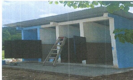
Foto 2: Reparación de piso de torta de concreto en baños.
