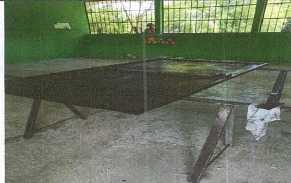
Foto 8: Sustitución de chapa.
