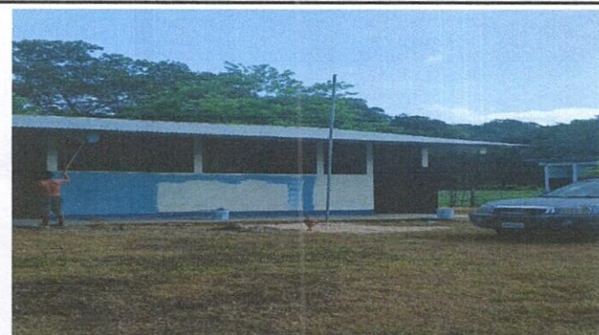
Foto 3: Pintura en muros exteriores e interiores
