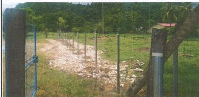
Foto 6: Reparación de tubo hg y malla galvanizada
