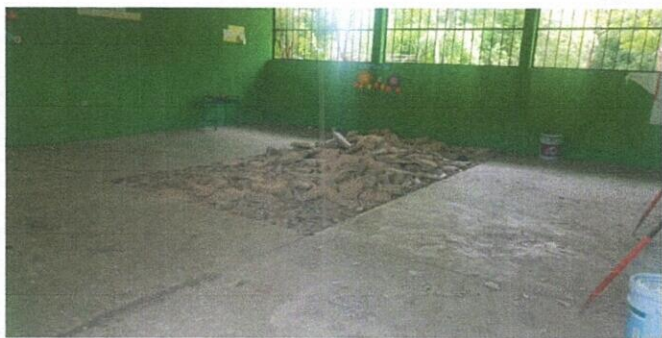
Foto 1: Suministro de piso cerámico
