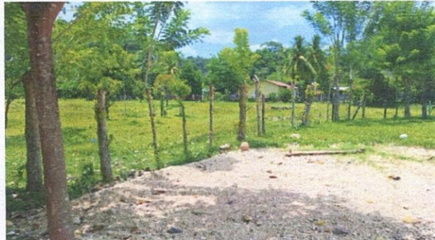
Foto 6: Reparación de tubo hg y malla galvanizada
