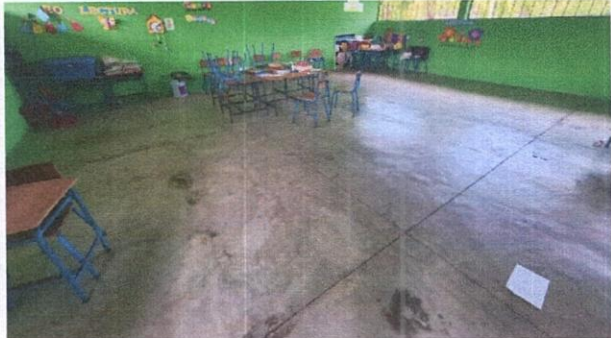
Foto 1: Suministro de piso cerámico
