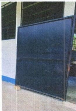
Foto 7: Mantenimiento a estructura de puertas de metal.
