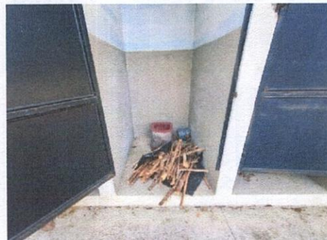
Foto 4: Cambio de letrinas por suministro de inodoros lavables
