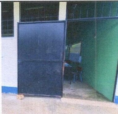
Foto 8: Sustitución de chapa.
