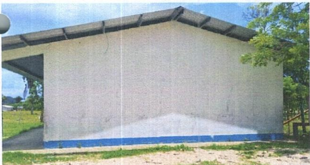
Foto 3: Pintura en muros exteriores e interiores
