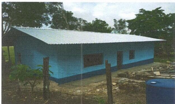
Foto 7: Pintura en muros exteriores e interiores
