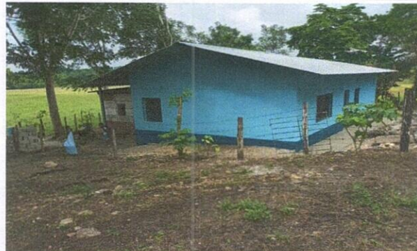
Foto 8: Repello en muros
