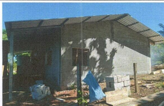
Foto 8: Repello en muros
