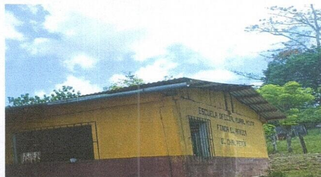
Foto 2: Sustitución de capote de lamina para lamina troquelada
