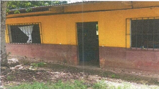
Foto 7: Pintura en muros exteriores e interiores
