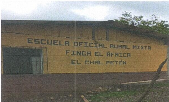
Foto 1: Sustitución de lamina troquelada aluzinc calibre 26
