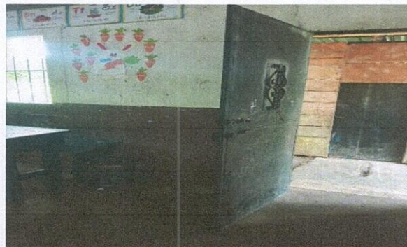
Foto 4: Sustitución de puerta
