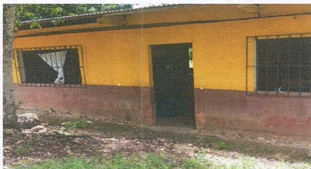
Foto 5: Mantenimiento a estructura de metal de ventana
