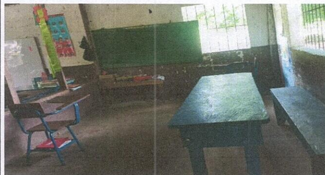
Foto 6: Reparacion de piso de torta de concreto
