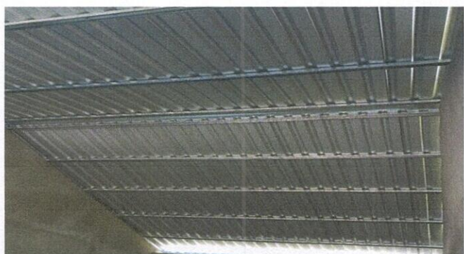
Foto 3: 2.1 Sustitución de estructura de soporte de madera, por metal
