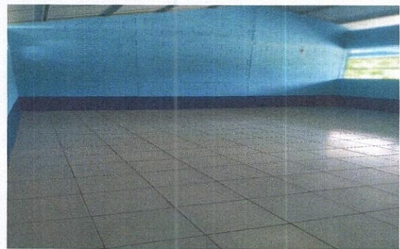
Foto 8: Pintura en muros exteriores e interiores
