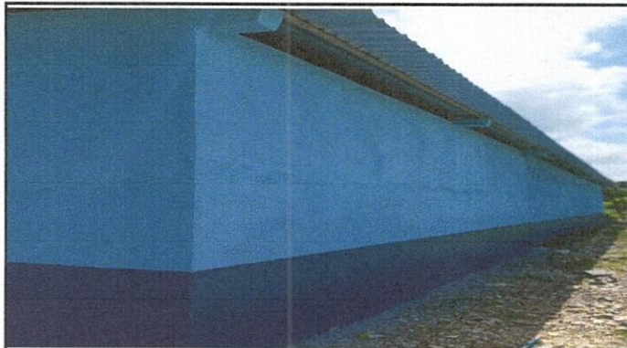
Foto 7: Pintura en muros exteriores e interiores
