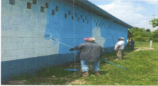
Foto 7: Pintura en muros exteriores e interiores
