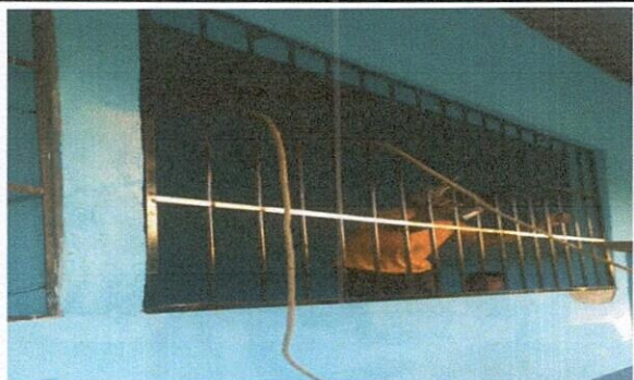
Foto 5: 5.2 Sustitución de estructura de metal de ventana
