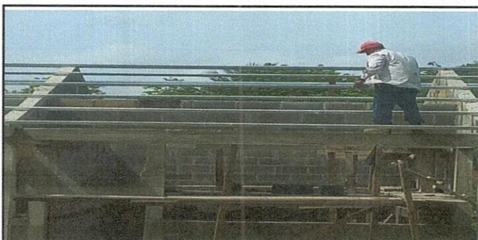
Foto 3: 2.1 Sustitución de estructura de soporte de madera, por metal
