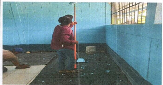
Foto 8: Pintura en muros exteriores e interiores
