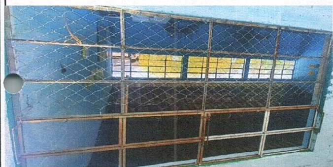
Foto 5: Sustitución de estructura de metal de ventana
