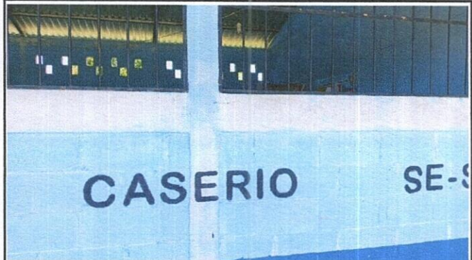
Foto 8: Pintura en muros exteriores e interiores
