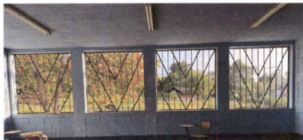
Foto 3: 19.1 Fabricación e instalación de ventanas
