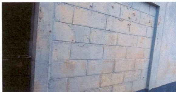
Foto 2: 9.1 Pintura en muros exteriores e interiores
