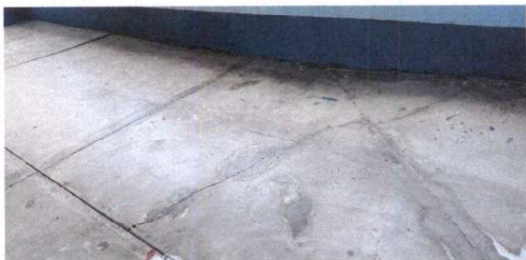
Foto 1: 6.5 Sustitución de piso
