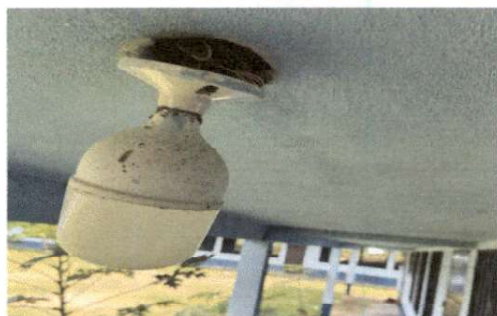
Foto 5: 17.3 Sustitución de lamparas tipo LED
