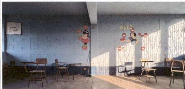
Foto 4: 21.1 Repello en muro
