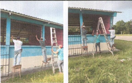
Foto 3: SUSTITUCIÓN DE LAMINA POR LAMINA TROQUELADA ALUZINC CALIBRE 16
