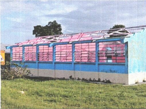
Foto 1: SUSTITUCIÓN DE ESTRUCTURA DE SOPORTE DE METAL POR METAL
