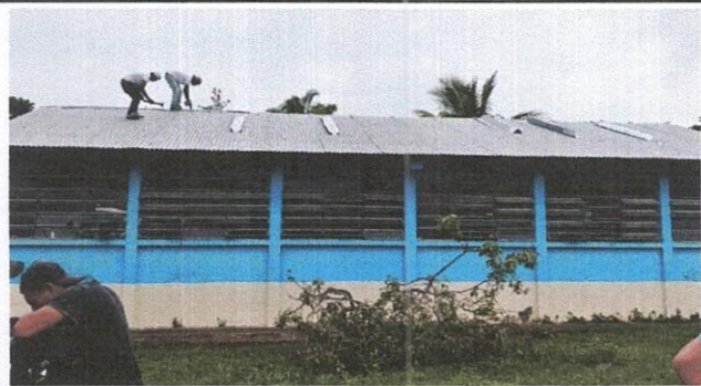
Foto 4: SUSTITUCIÓN DE CAPOTE DE LAMINA PARA LAMINA TROQUEDA
