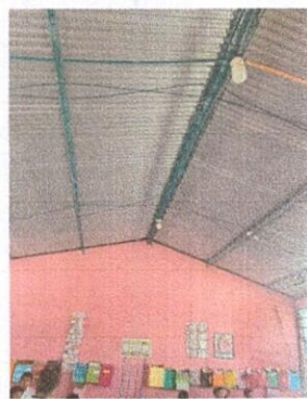
Foto: 4 1.2 Sustitución de capote de lámina para lámina troquelada
