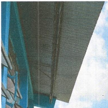
Foto 1: 2.3 Sustitución de estructura de soporte de metal por metal
