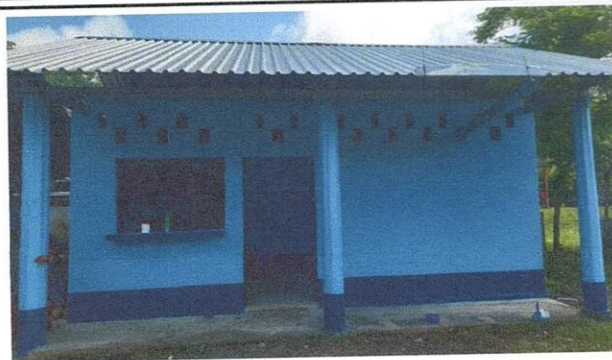
Foto 2: MANTENIMIENTO A ESTRUCTURA DE METAL DE VENTANA
