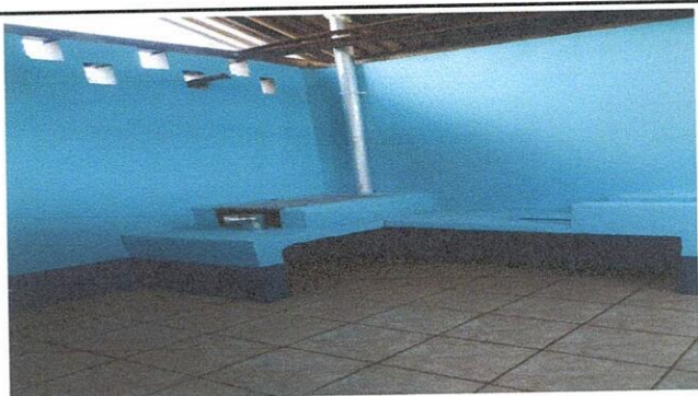
Foto 5: SUSTITUCION DE ESTUFA RURAL (COMPLETA) INCLUYE CHIMENEA Y PLANCHA
