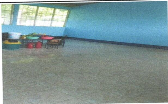
Foto 3: MEJORAMIENTO DE PISO
