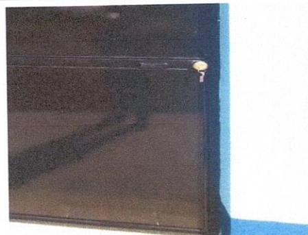
Foto 6: SUSTITUCION DE CHAPA
