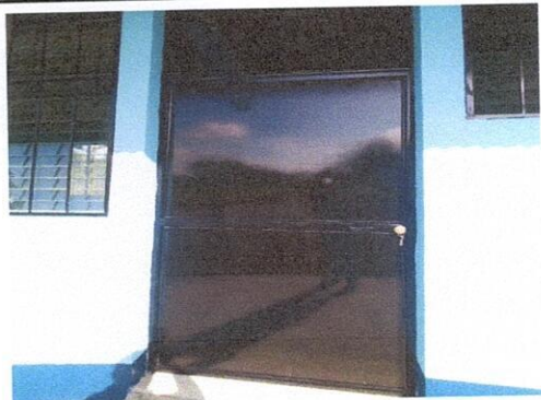
Foto 1: MANTENIMIENTO A PUERTAS (LIJADO, CEPILLADO, APLICACIÓN DE PINTURA EN 5 PUERTAS)
