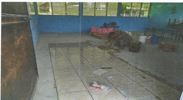
Foto: 3 MEJORAMIENTO DE PISO
