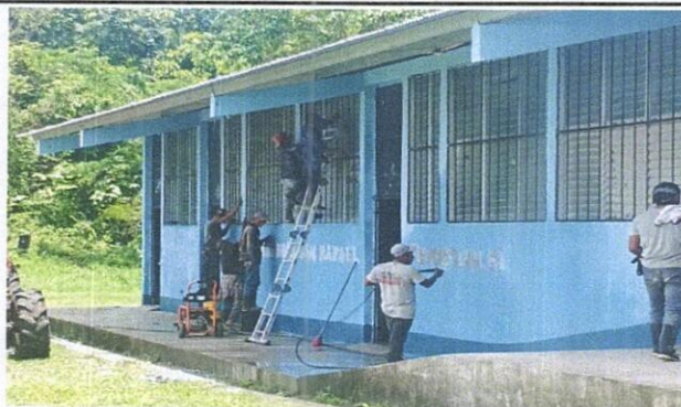
Foto: 4 PINTURA EN MUROS DE INTERIORES Y EXTERIORES
