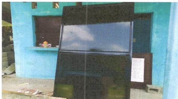
Foto 1: MANTENIMIENTO A PUERTAS (LIJADO, CEPILLADO, APLICACIÓN DE PINTURA EN 5 PUERTAS)
