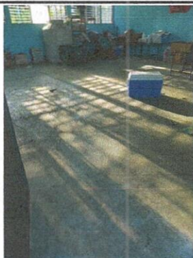
Foto 3: MEJORAMIENTO DE PISO
