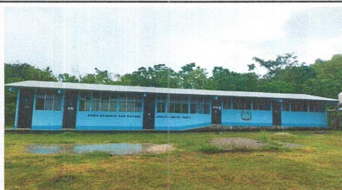
Foto 4: PINTURA EN MUROS DE INTERIORES Y EXTERIORES
