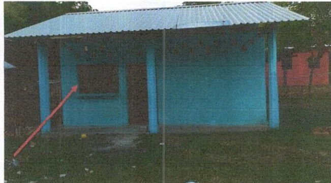
Foto 2: MANTENIMIENTO A ESTRUCTURA DE METAL DE VENTANA
