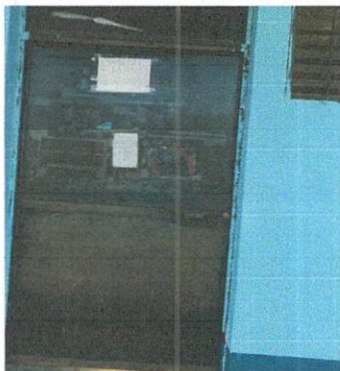
Foto 1: MANTENIMIENTO A PUERTAS (LIJADO, CEPILLADO, APLICACIÓN DE PINTURA EN 5 PUERTAS)
