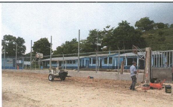
Foto 3: REPARACIÓN DEL CERCO DE LADO SUR
