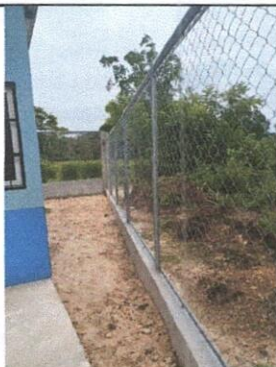
Foto 1: REPARACIÓN DEL CERCO DE LADO OESTE
