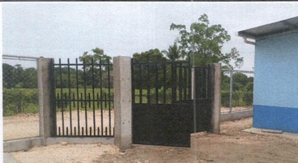
Foto 6: SUSTITUCIÓN DE PORTON
