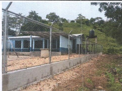
Foto 2: REPARACIÓN DEL CERCO DE LADO NORTE
