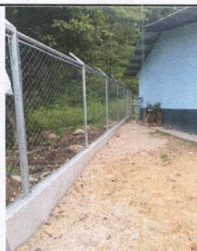
Foto 4: REPARACIÓN DEL CERCO DE LADO SUR
