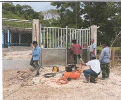
Foto 5: SUSTITUCIÓN DE PORTÓN DOBLE HOJA
