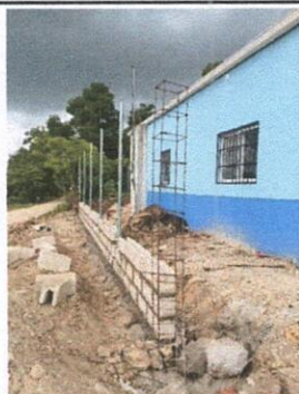
Foto 3: REPARACIÓN DEL CERCO DE LADO SUR
