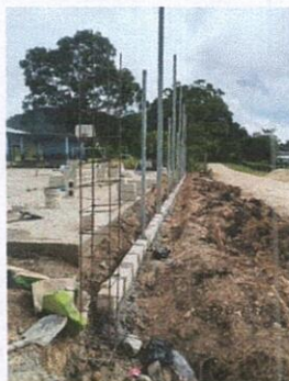
Foto 4: REPARACIÓN DEL CERCO DE LADO SUR
