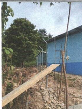
Foto 1: REPARACIÓN DEL CERCO DE LADO OESTE
