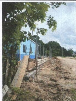
Foto 2: REPARACIÓN DEL CERCO DE LADO NORTE
