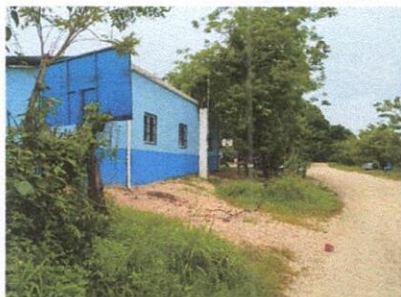
Foto 3: REPARACION DEL CERCADO LADO SUR
