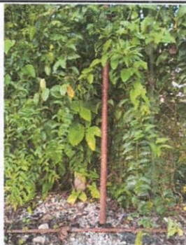
Foto 4: REPARACION DEL CERCO LADO SUR
