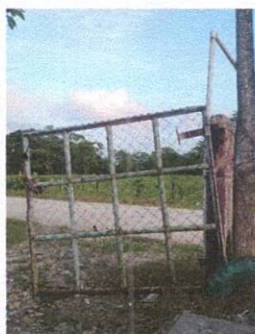
Foto: SUSTITUCIÓN DE PORTÓN DE DOBLE HOJA
