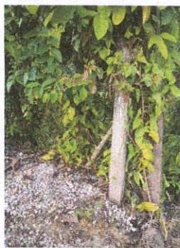
Foto 2: REPARACION DEL CERCO LADO NORTE
