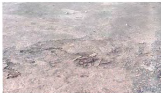
Foto 8: 6.5 Sustitución de piso de torta de concreto
