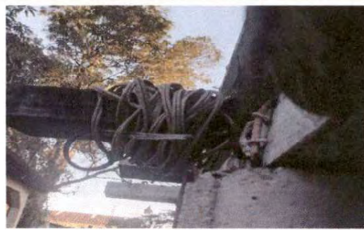
Foto 14: 17.11 Reparación de cableado electrico
