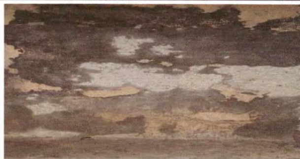
Foto 18: 21.1 Repello en muro
