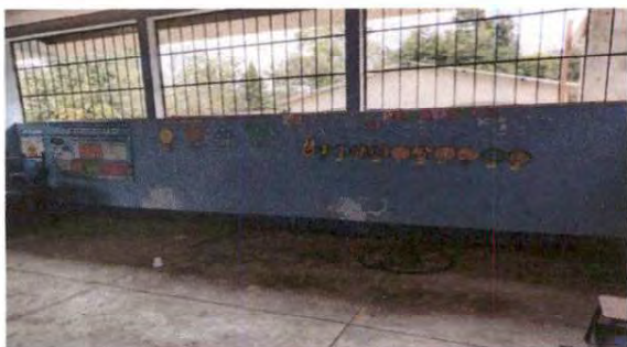
Foto 7: 5.1 Mantenimiento a estructura de metal de ventana
