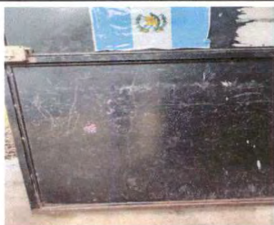
Foto 5: 4.1 Mantenimiento a estructura (lijado, cambio de tubo, cepillado, sujeciones, aplicación de pintura)
