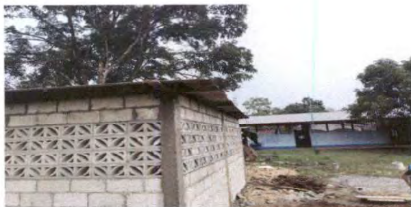
Foto1: 1.1 Sustrucción de lámina, por lámina troquelada aluzinc calibre 26.
