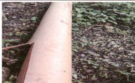
Foto 12: 14.1 Sustitución de tubería PVC línea principal aguas negras
