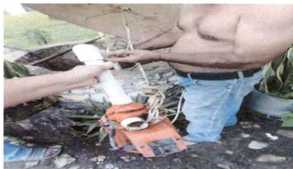
Foto 16: 18.7 Sustitución de bomba de agua
