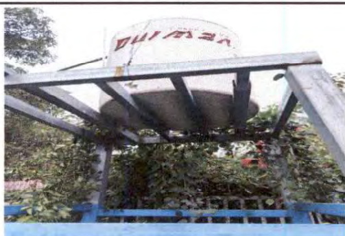
Foto 15: 18.3 Sustitución de deposito de agua 1700 lt
