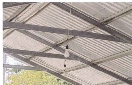
Foto 6: Sustitución de lámparas tipo LED
