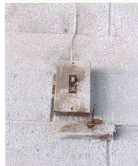
Foto 4: Sustitución de tablero de flípones
