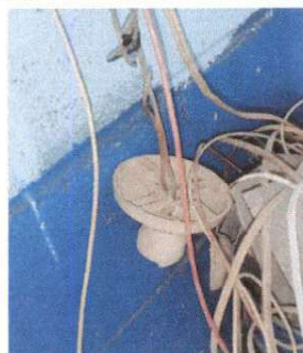
Foto 5: Sustitución de plafoneras
