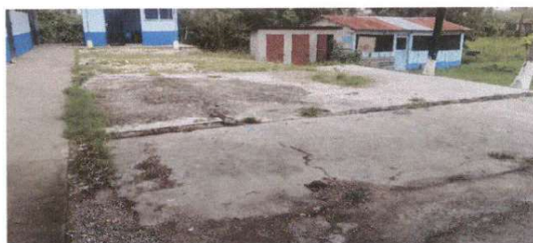
Foto 10: Reparación de plancha de concreto de patio
