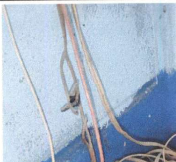
Foto 7: Reparación de cableado eléctrico
