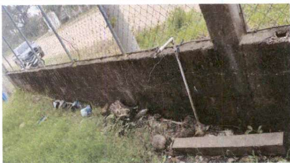
Foto 1: Reparación de muro perimetral de block
