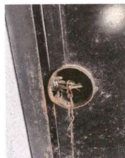
Foto 8: Sustitución de chapa
