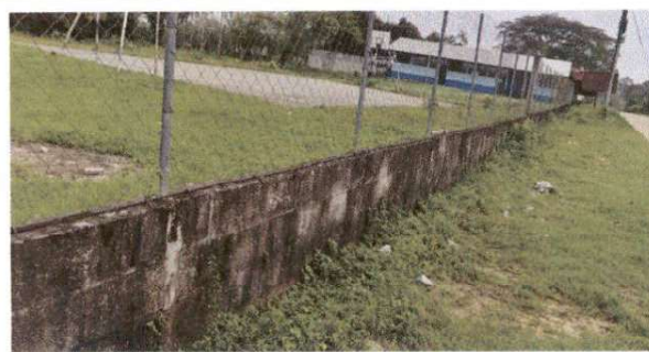
Foto 2: Reparación de tubo hg y malla galvanizada
