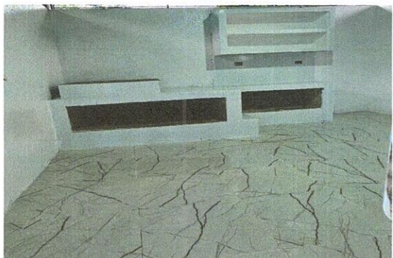
Foto 1: 13 Mejoramiento de azulejo en cocina
