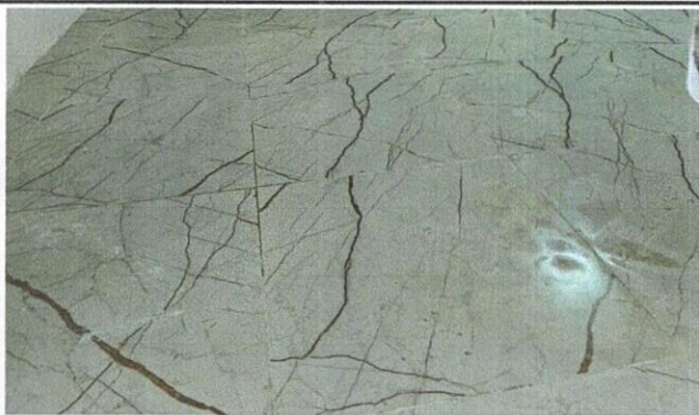
Foto 3: (Mejoramiento de piso) piso cerámico
