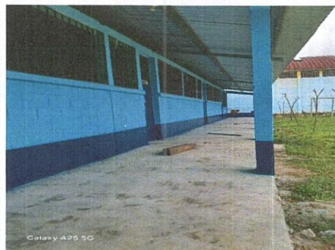
Foto 2: 6.2 Sustitución de piso de torta de concreto
