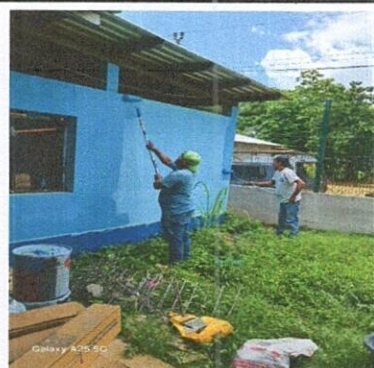
Foto 4: 4.9 Pintura en muros exteriores e interiores
