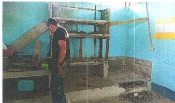
Foto 2: 20.8 Reparacion de azulejo en muebles de cocina
