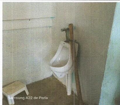
Foto 6: 6.8 Sustitucion de mingitorio
