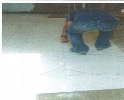
Foto 3: (Mejoramiento de piso) piso cerámico
