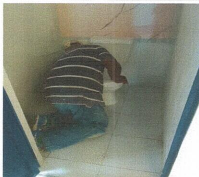
Foto 5:10.3 Sustitucion de inodoro
