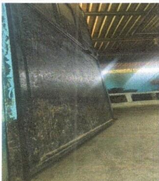
Foto 1: 4.1 Mantenimiento a estructura (lijado, cambio de tubo, cepillado, sujeciones, aplicación de pintura)
