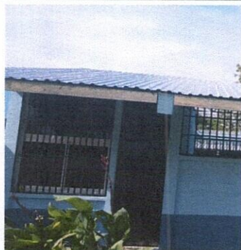
Foto: 3 SUSTITUCIÓN DE ELEMENTOS DE FIJACIÓN
