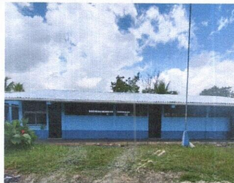
Foto: 2 SUSTITUCIÓN DE CAPOTE DE LÁMINA PARA LÁMINA TROQUELADA
