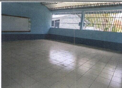
Foto: 5 MEJORAMIENTO DE PISO
