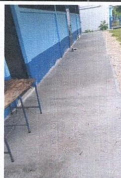
Foto: 4 REPACIÓN DE TORTA DE CONCRETO
