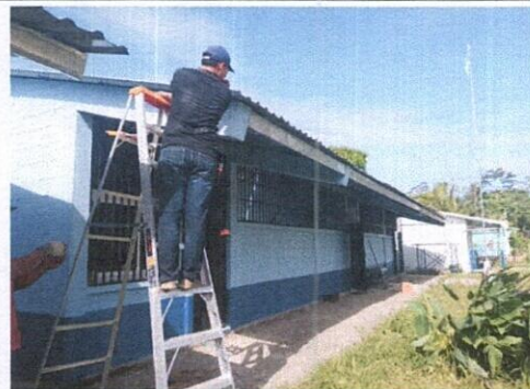
Foto: 6 SUMINISTRO DE CANAL DE METAL
