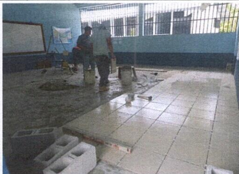
Foto: 5 MEJORAMIENTO DE PISO
