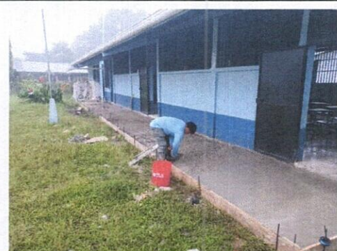
Foto: 4 REPACIÓN DE TORTA DE CONCRETO
