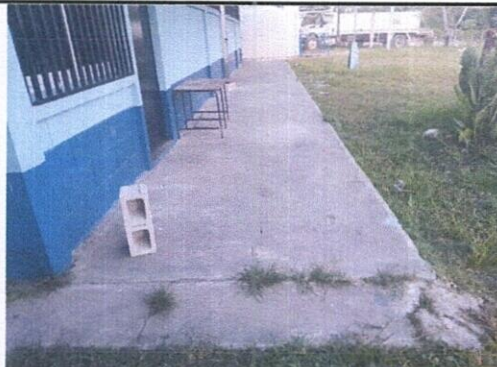
Foto: 4 REPACCIÓN DE TORTA DE CONCRETO
