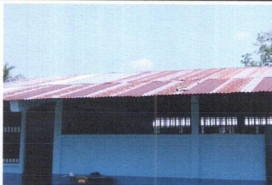
Foto: 3 SUSTITUCIÓN DE ELEMENTOS DE FIJACIÓN
