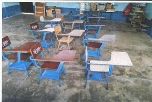
Foto: 5 MEJORAMIENTO DE PISO
