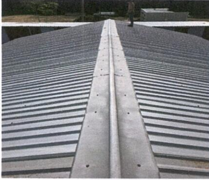
Foto 1: SUSTITUCIÓN DE CAPOTE DE LÁMINA POR LÁMINA TROQUELADA
