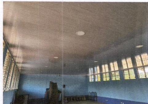
Foto 6: FABRICACIÓN E INSTALACIÓN DE CIELO FALSO
