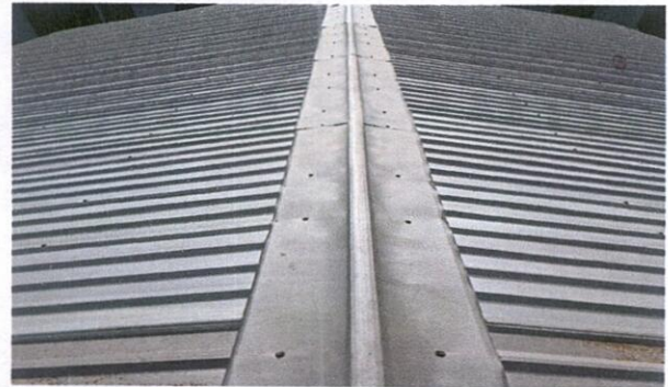
Foto 2: SUSTITUCIÓN DE CAPOTE DE LÁMINA POR LÁMINA TROQUELADA
