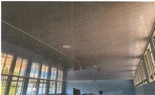
Foto 5: FABRICACIÓN E INSTALACIÓN DE CIELO FALSO
