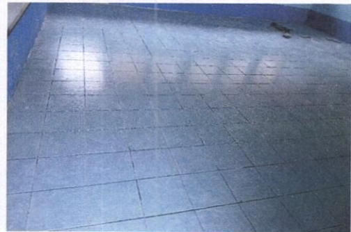
Foto 4: SUSTITUCIÓN DE PISO DE CEMENTO LÍQUIDO POR CERAMICA
