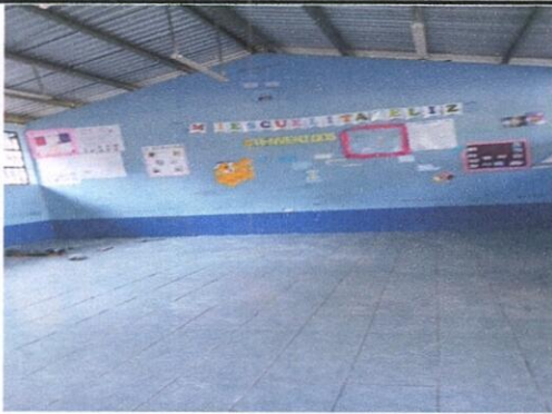
Foto 3: SUSTITUCIÓN DE PISO DE CEMENTO LÍQUIDO POR CERAMICA
