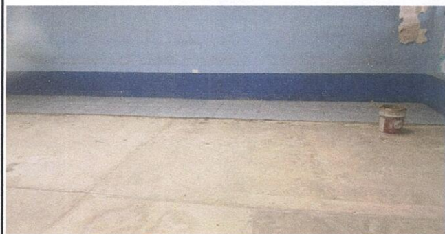
Foto 3: SUSTITUCIÓN DE PISO DE CEMENTO LÍQUIDO POR CERAMICA
