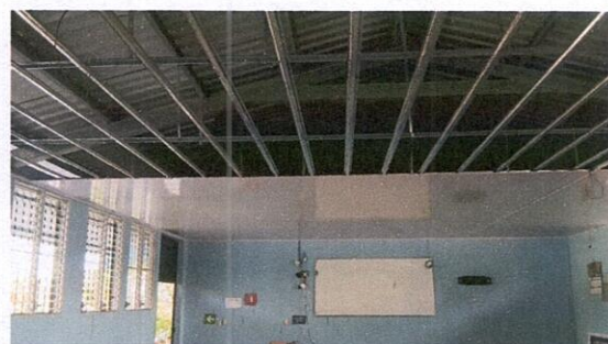
Foto 6: FABRICACIÓN E INSTALACIÓN DE CIELO FALSO
