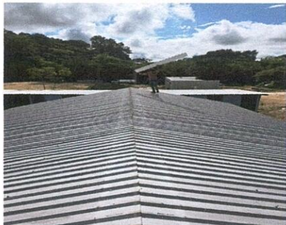
Foto 1: SUSTITUCIÓN DE CAPOTE DE LÁMINA POR LÁMINA TROQUELADA
