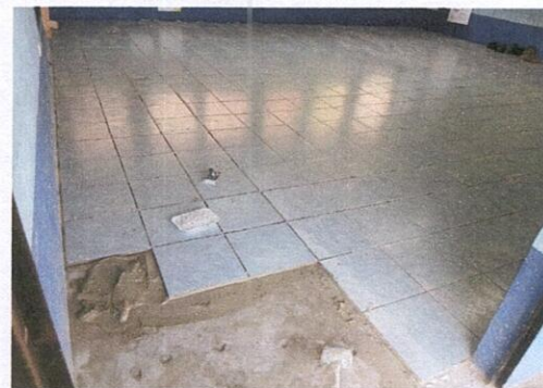
Foto 4: SUSTITUCIÓN DE PISO DE CEMENTO LÍQUIDO POR CERAMICA
