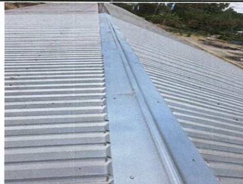
Foto 2: SUSTITUCIÓN DE CAPOTE DE LÁMINA POR LÁMINA TROQUELADA
