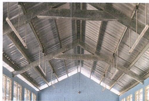
Foto 2: SUSTITUCIÓN DE CAPOTE DE LÁMINA POR LÁMINA TROQUELADA
