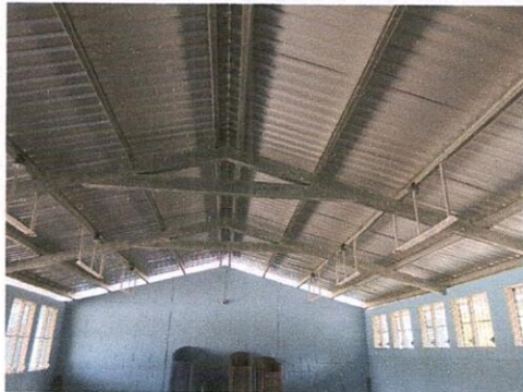
Foto 1: SUSTITUCIÓN DE CAPOTE DE LÁMINA POR LÁMINA TROQUELADA
