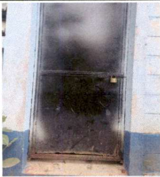
Foto1: SUSTITUCIÓN DE PUERTA
