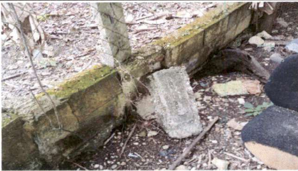
Foto 3: REPARACIÓN DE MURO PERIMETRAL DE BLOCK
