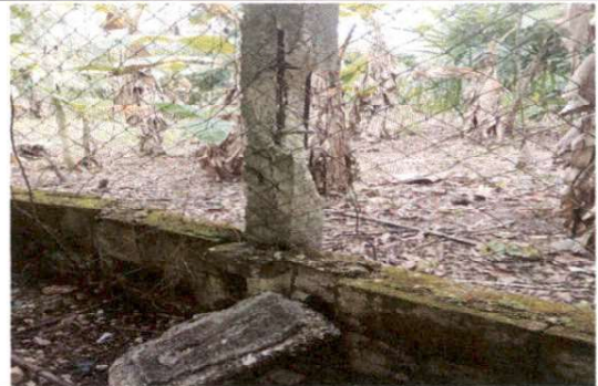
Foto 4: REPARACIÓN DE TUBO HG Y MALLA GALVANIZADA
