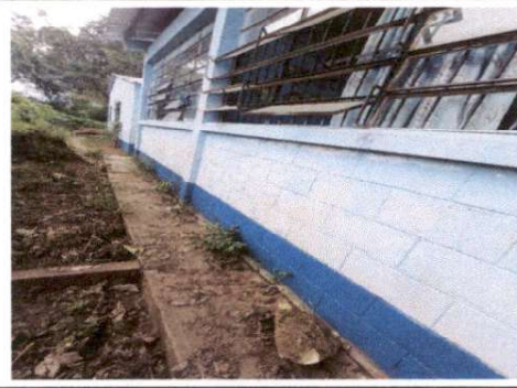
Foto 2: PINTURA EN MUROS EXTERIORES E INTERIORES
