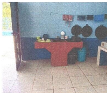
FOTO 10: SUSTITUCION DE PILA DE DOS LAVADERO
