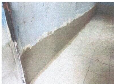
Foto 11: REPELLO EN MURO
