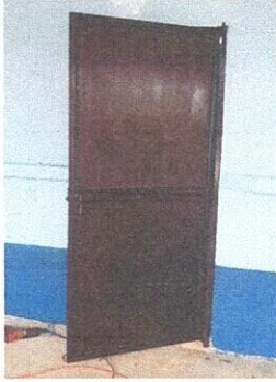
Foto 1: MANTENIMIENTO PUERTAS DE METAL
