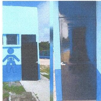
Foto 8: MANTENIMIENTO A ESTRUCTURAS DE BAÑO (PUERTAS)
