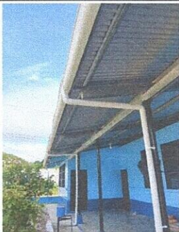
Foto 5: sustitucion de canal de PVC
