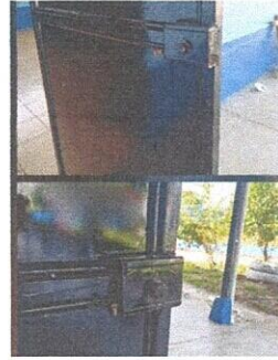
Foto 2: SUSTITUCION DE CHAPA
