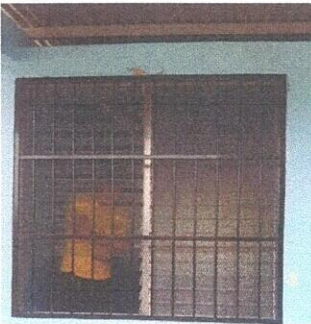
Foto 3: MANTENIMIENTOS DE BALCONES
