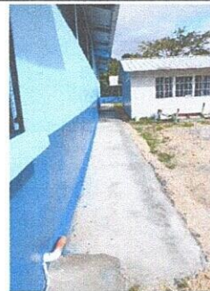
Foto 6: Reparacion de banqueta de concreto
