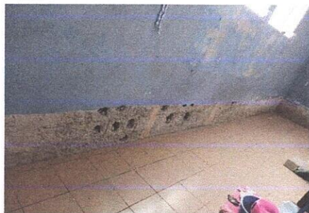
Foto 11: REPELLO EN MURO
