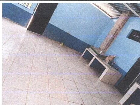
FOTO 10: SUSTITUCION DE PILA DE DOS LAVADERO
