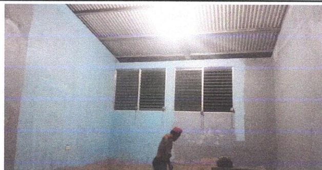
Foto 7: PINTURA EN MUROS EXTERIORES E INTERIORES
