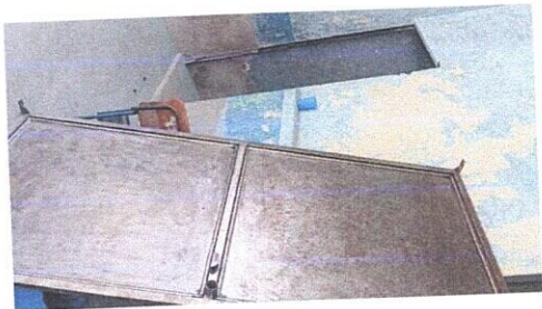
Foto 1: MANTENIMIENTO PUERTAS DE METAL
