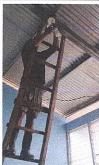
Foto 9: SUSTITUCION DE FOCOS AHORRADORES
