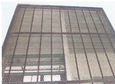
Foto 3: MANTENIMIENTOS DE BALCONES
