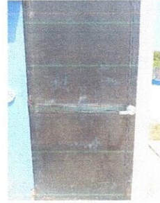
Foto 8 MANTENIMIENTO A ESTRUCTURAS DE BAÑO (PUERTAS )
