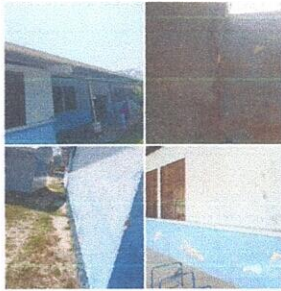
Foto 7: PINTURA EN MUROS EXTERIORES E INTERIORES
