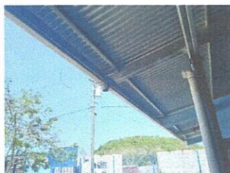
Foto 5: sustitucion de canal de PVC
