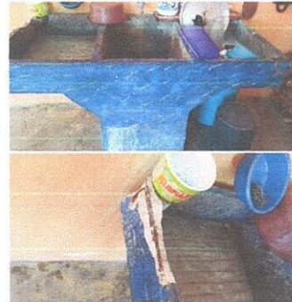
FOTO 10: SUSTITUCION DE PILA DE DOS LAVADERO
