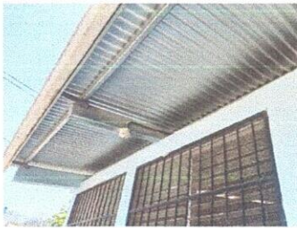
Foto 9 SUSTITUCION DE FOCOS AHORRADORES
