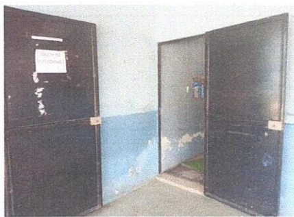
Foto 1: MANTENIMIENTO PUERTAS DE METAL
