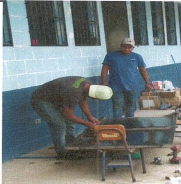
Foto1: Sustitución de chapa
