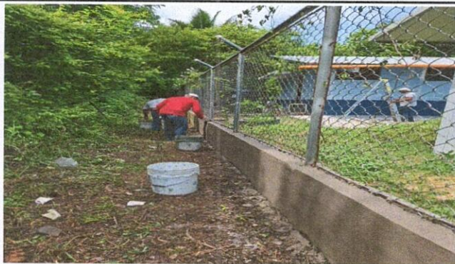
Foto 3: Repello en muro
