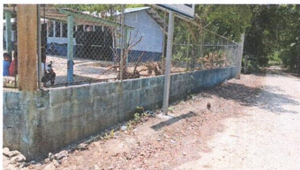
Foto 3: Repello en muro
