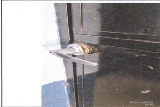
Foto 1: Sustitución de chapa
