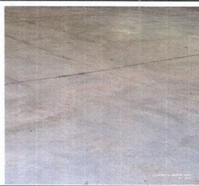
Foto 2: Mejoramiento de piso
