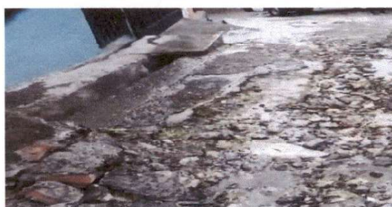
Foto 8: 8.1 Reparación de cuneta de concreto
