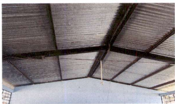
Foto1: 2.1 Mantenimiento a estructura de soporte de metal
