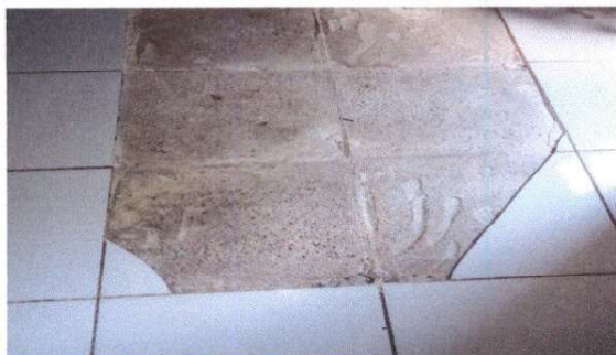
Foto7: 6.8 Sustitucion de piso ceramico
