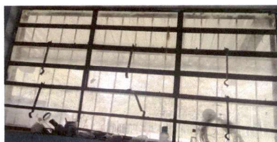
Foto 4: 5.1 Mantenimiento a estructura de metal de ventana
