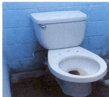
Foto 10: 10.1 Sustitucion de inodoro
