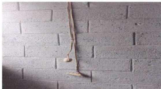
Foto 12: 17.11 Reparacion de cableado electrico
