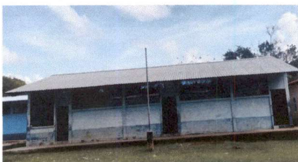
Foto 9: 9.1 Pintura en muros exteriores e interiores
