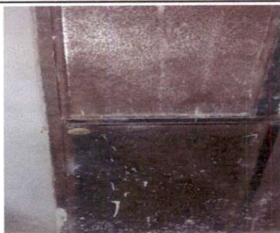
Foto 3: 4.2 Sustitución de chapa
