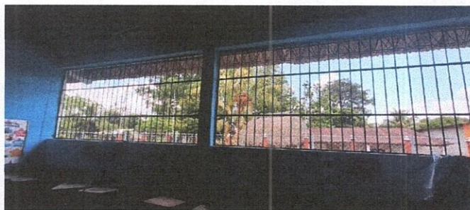
Foto: 3 Sustitución de balcones de metal
