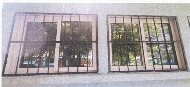
Foto: 4 Instalación de ventanas de PVC
