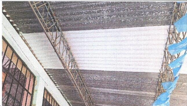
Foto: 1 Cambio de lámina acanalada por lámina acanalada aluzinc calibre 26
