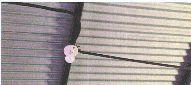
Foto: 6 Sustitución de focos ahorradores y plafoneras
