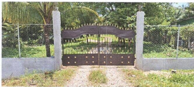
Foto: 9 Fabricación e intalación de portón de metal de ingreso
