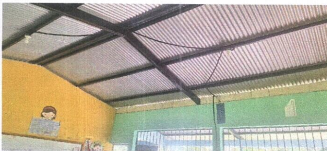
Foto: 8 Sustitución del cableado eléctrico, ducto eléctrico más accesorios
