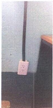
Foto: 7 Sustitución de interruptores y toma corrientes dobles
