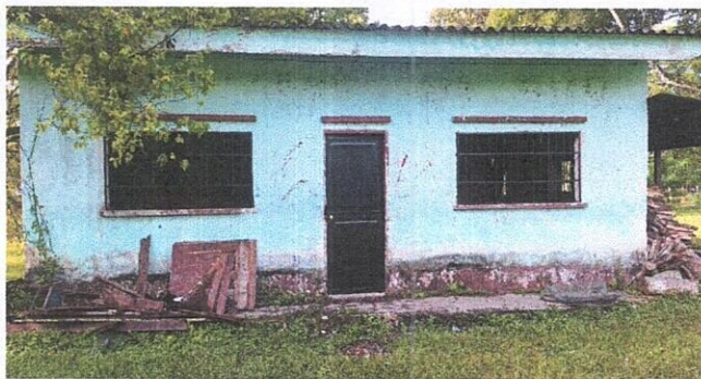
Foto: 2 Sustitución de puerta de metal
