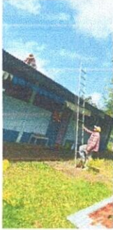
Foto 1 Cambio de lámina acanalada por lámina acanalada aluzinc calibre 26
