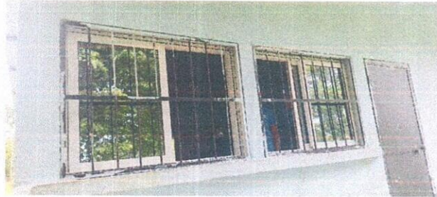
Foto 4 Instalación de ventana de ventanas PVC
