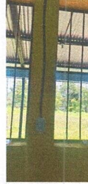
Foto: 8 Sustitución del cableado eléctrico, ducto eléctrico más accesorios
