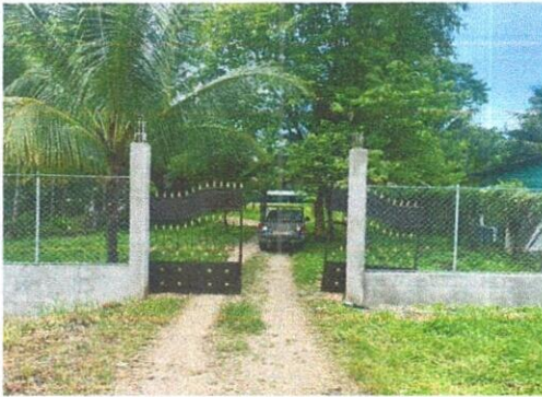
Foto: 9 Fabricación e intalación de portón de metal de ingreso
