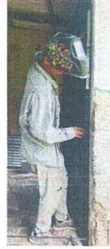
Foto 2 Sustitución de puerta de metal
