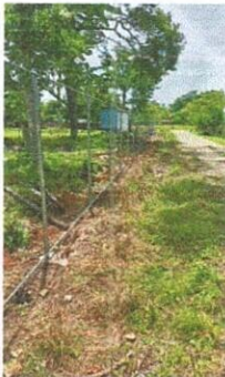
Foto 5 Reparación de tubo Hg y malla galvanizada
