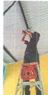
Foto 6 Sustitución de focos ahorradores
