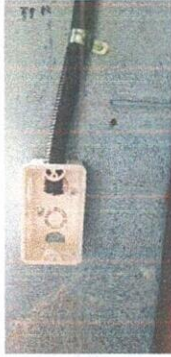
Foto: 7 Sustitución de interruptores y toma corrientes dobles
