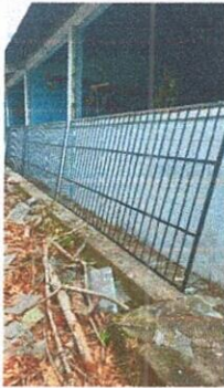
Foto 3 Sustitución de balcones de metal
