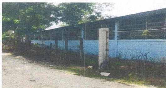
Foto: 5 Reparación de tubo Hg y malla galvanizada
