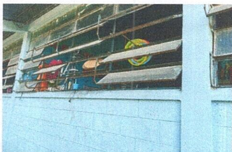
Foto: 3 Sustitución de balcones de metal
