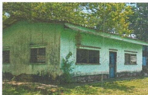
Foto: 2 Sustitución de puerta de metal
