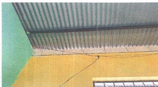
Foto: 8 Sustitución del cableado eléctrico, ducto eléctrico más accesorios
