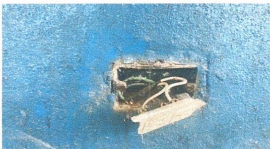
Foto: 7 Sustitución de interruptores y toma corrientes dobles
