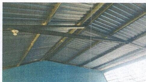
Foto: 6 Sustitución de focos ahorradores y plafoneras
