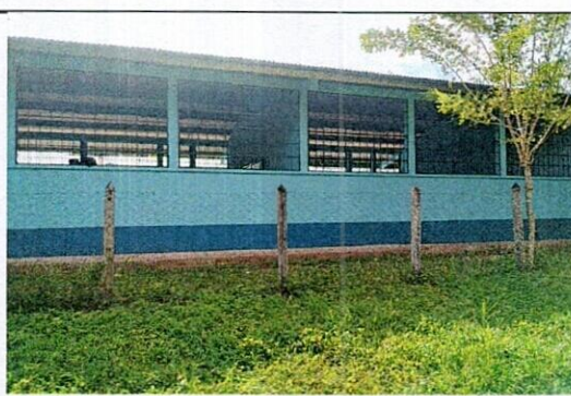
Foto 12: Mantenimiento a balcon de metal
