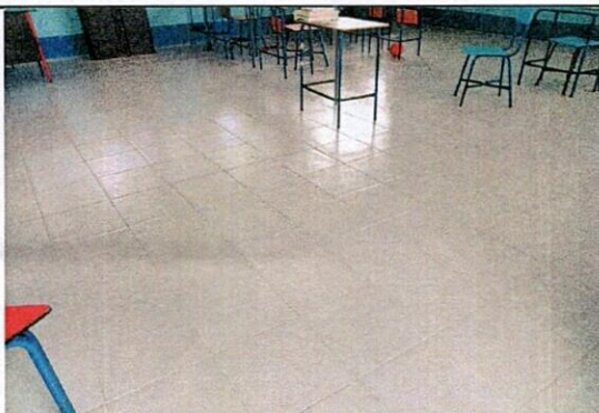
Foto 3: Suministro de piso cerámico.
