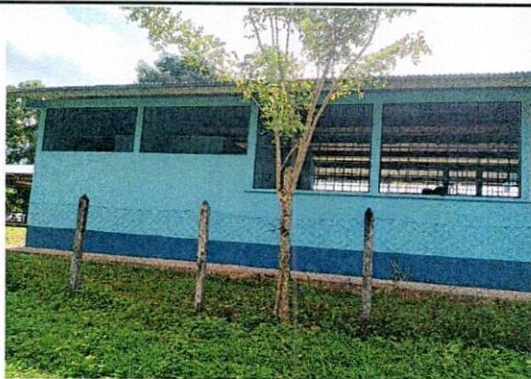
Foto 7: Mantenimiento a balcon de metal
