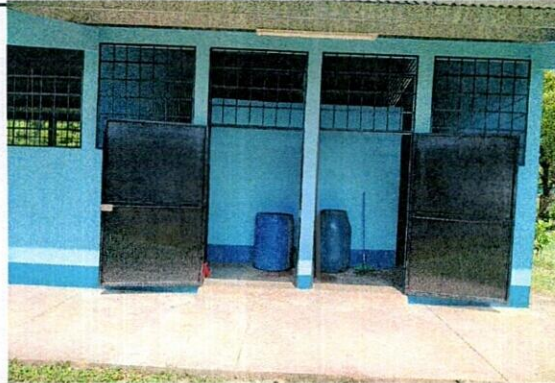
Foto 2: Mantenimiento a estructura de puertas de metal.
