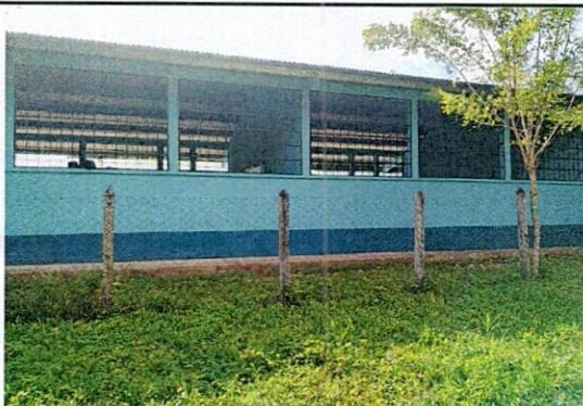
Foto 9: Mantenimiento a balcon de metal
