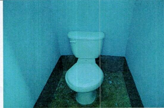
Foto 6: Sustitución de accesorios inodoro (contra llave, tubo de abasto y tanque)
