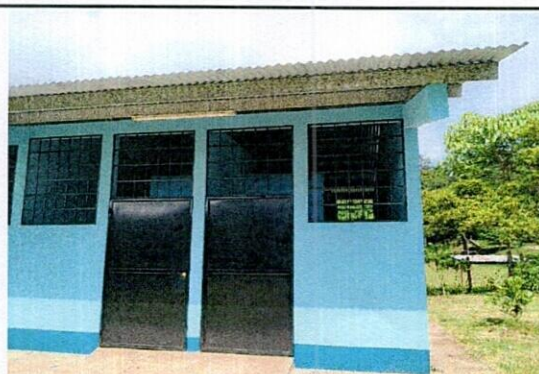
Foto 10: mantenimiento a estructura(lijado, cambio de tubo, cepillado, sueciones, aplicaciones de pintura)
