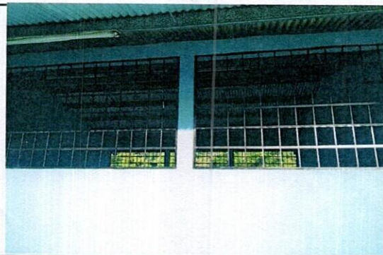
Foto 12: Mantenimiento a balcon de metal
