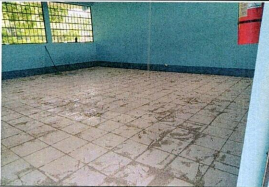
Foto 3: Suministro de piso cerámico.
