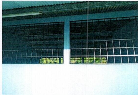
Foto 8: Mantenimiento a balcon de metal
