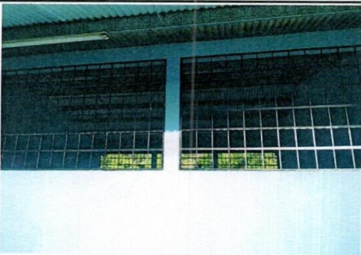
Foto 9: Mantenimiento a balcon de metal
