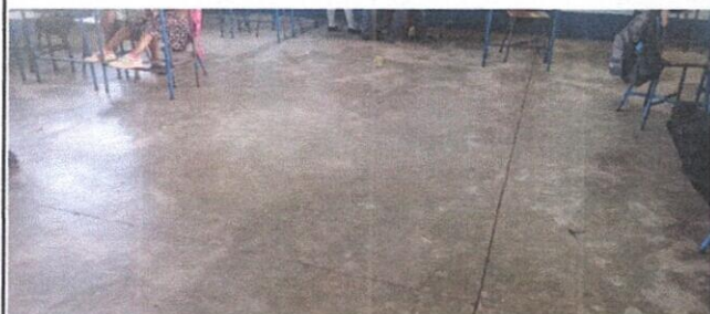
Foto 3: Suministro de piso cerámico.
