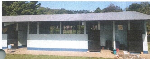
Foto 1: Sustitución de capote de lámina.
