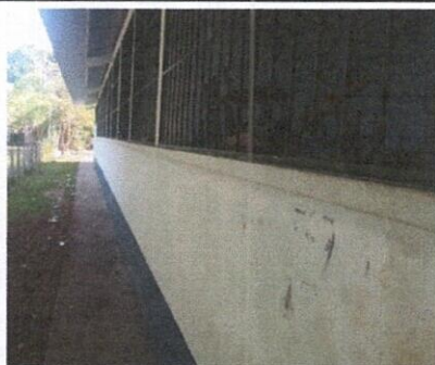
Foto 5: Pintura en muros exteriores e interiores.
