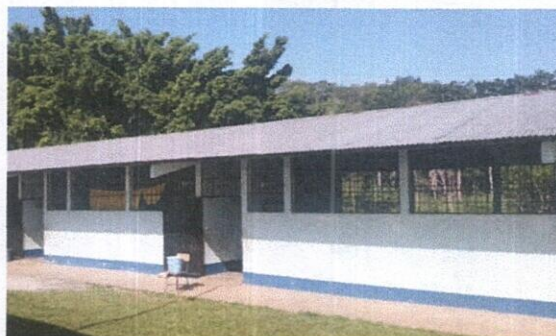
Foto 4: Pintura en muros exteriores e interiores.
