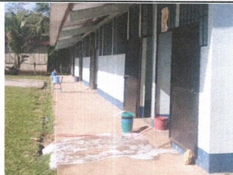
Foto 2: Mantenimiento a estructura de puertas de metal.
