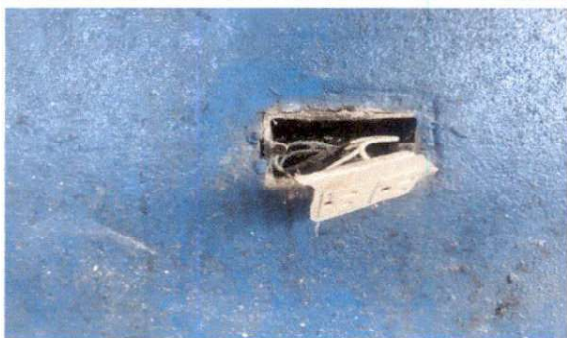
Foto 9: Sustitución de tomacorrientes dobles
