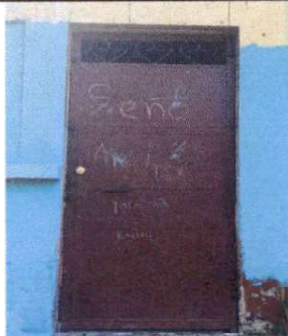
Foto 3: 4.3 Fabricación e instalación de puertas de metal
