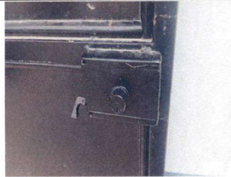
Foto 2: 4.1 Sustitución de Chapa
