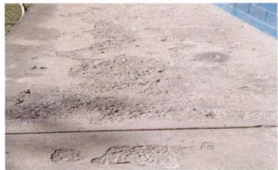
Foto 4: 6.5 Sustitución de piso de torta de concreto
