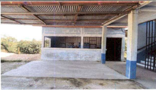
Foto 1. 2.2 Sustitución de estructura de soporte de madera, por metal
