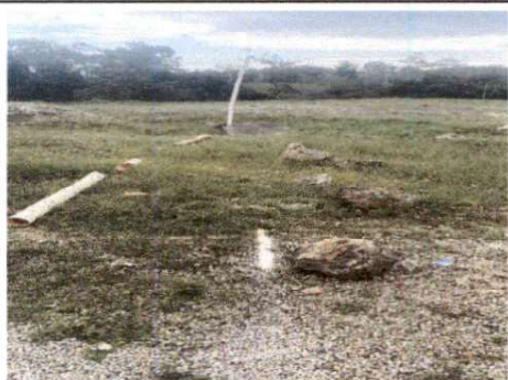
Foto 7. 14.3 Sustitución de tuberías PVC línea principal aguas negras
