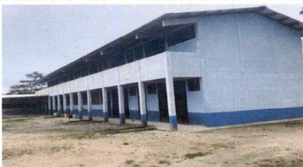
Foto 5: 9.1 Pinturas en muros exteriores e interiores
