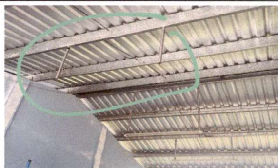
Foto 8: Sustitución de lámparas tipo LED
