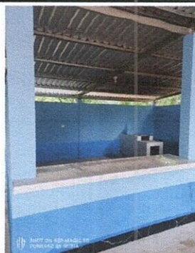
Foto 5: Pintura en muros exteriores e interiores
