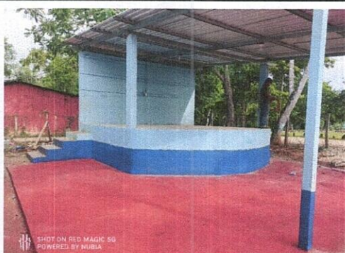
Foto 4: Sustitución de piso de torta de concreto
