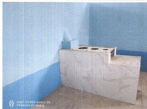
Foto 2: Instalación de azulejo en estufa rural
