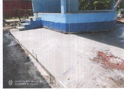
Foto 4: Sustitución de piso de torta de concreto
