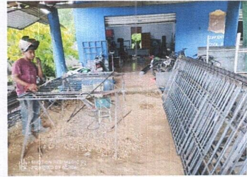
Foto 6: Fabricación e instalación de balcones de hierro en ventana
