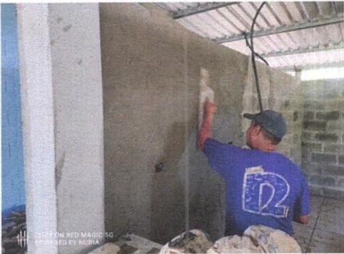
Foto 3: Repello en muro
