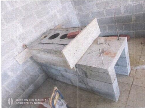
Foto 1: Sustitución de estufa rural (completa) incluye chimenea y plancha de metal
