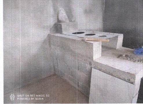
Foto 2: Instalación de azulejo en estufa rural
