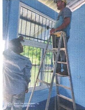
Foto 8: Sustitución de estructura de metal de ventana a PVC
