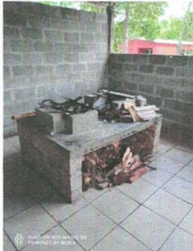
Foto 1: Sustitución de estufa rural (completa) incluye chimenea y plancha de metal
