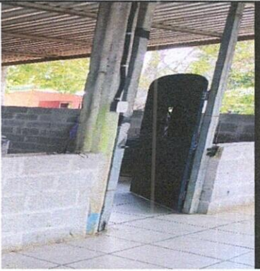
Foto 7: Fabricación e instalación de puerta de rejas
