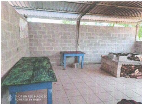
Foto 3: Repello en muro
