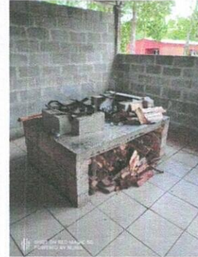
Foto 2: Instalación de azulejo en estufa rural
