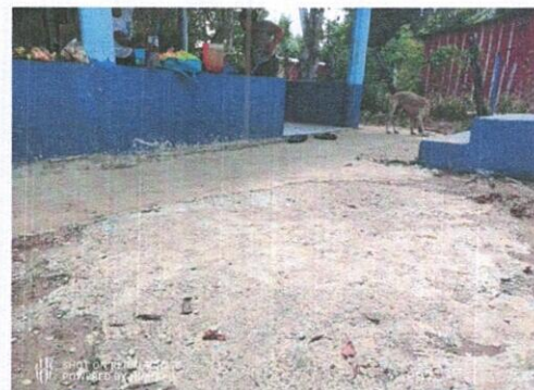
Foto 4: Sustitución de piso de torta de concreto
