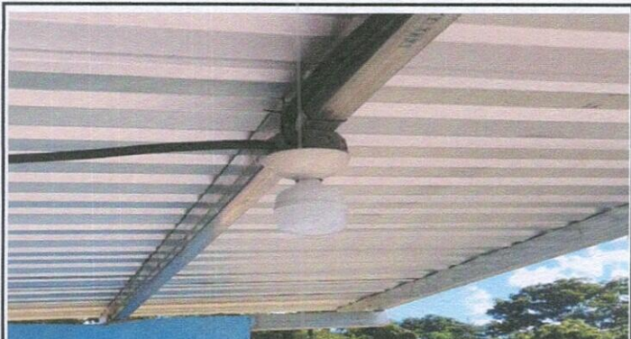
Foto 4: SUSTITUCION DE CABLEADO ELECTRIO
