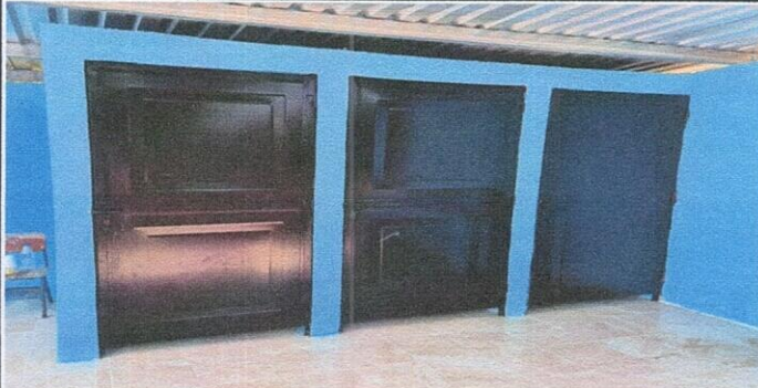
Foto 6: SUSTITUCION DE PUERTA DE METAL
