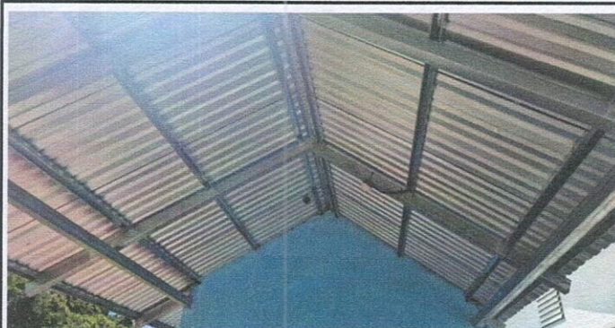
Foto 4: SUSTITUCION DE ESTRUCTURA DE SOPORTE
