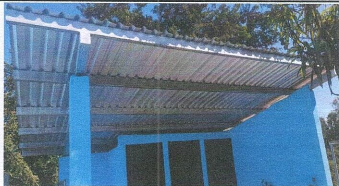
Foto 1: SUSTITUCION DE TECHO
