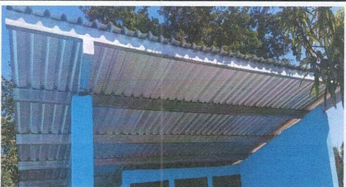
Foto 3: SUSTITUCION DE ESTRUCTURA DE SOPORTE
