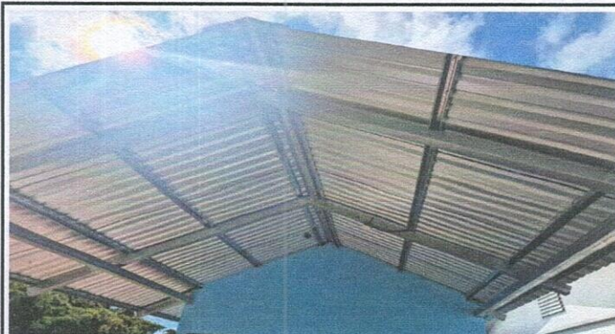
Foto 2: SUSTITUCION DE TECHO
