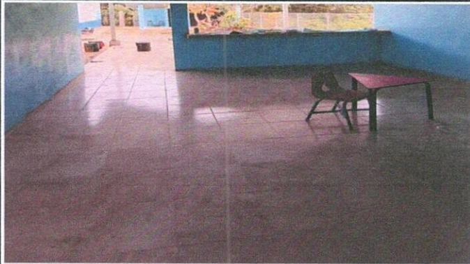
Foto 1: SUSTITUCION DE PISO
