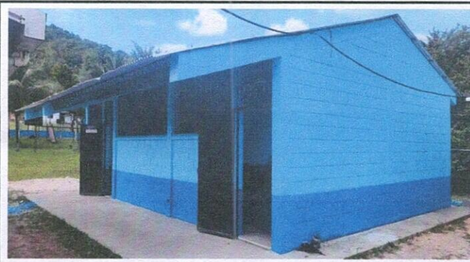
Foto 3: PINTURA EN MUROS
