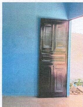
Foto 5: SUSTITUCION DE PUERTAS DE METAL
