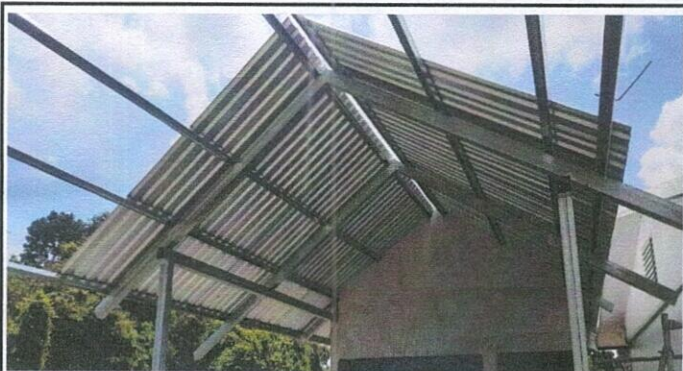
Foto 3: SUSTITUCION DE ESTRUCTURA DE SOPORTE
