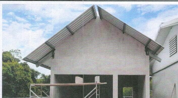
Foto 2: SUSTITUCION DE TECHO
