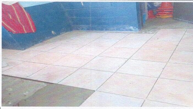
Foto 1: SUSTITUCION DE PISO
