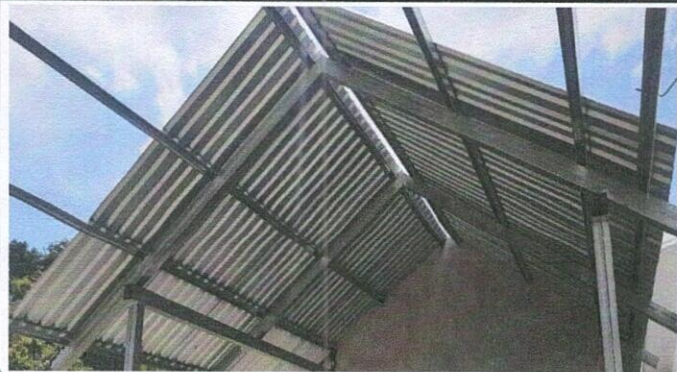
Foto 1: SUSTITUCION DE TECHO
