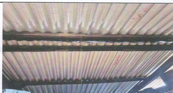
Foto 3: SUSTITUCION DE ESTRUCTURA DE SOPORTE
