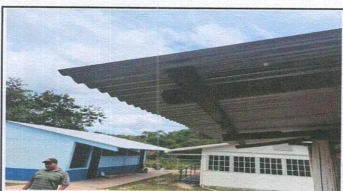
Foto 4: SUSTITUCION DE ESTRUCTURA DE SOPORTE
