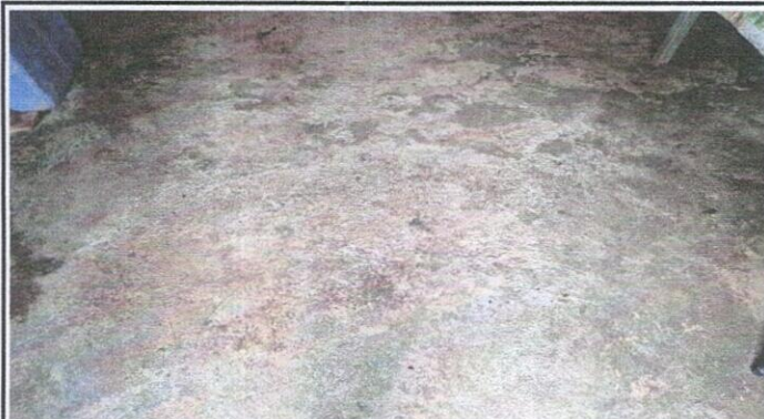
Foto 2: SUSTITUCION DE PISO
