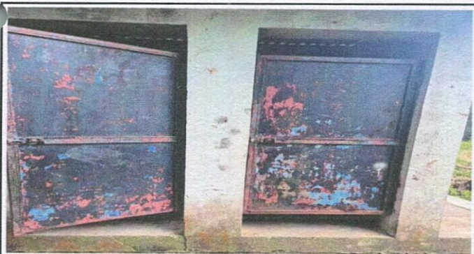
Foto 5: SUSTITUCION DE PUERTAS DE METAL
