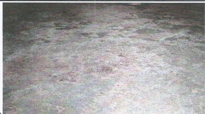
Foto 1: SUSTITUCION DE PISO
