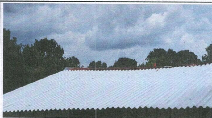
Foto 2: SUSTITUCION DE TECHO
